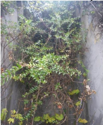
A 8 Canale di scolo Strada provinciale 1
