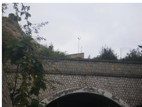
G 4 Telecamera ingresso galleria Mortola
