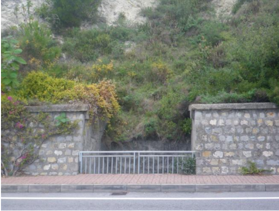
A 6 Canale di scolo Strada provinciale 1
