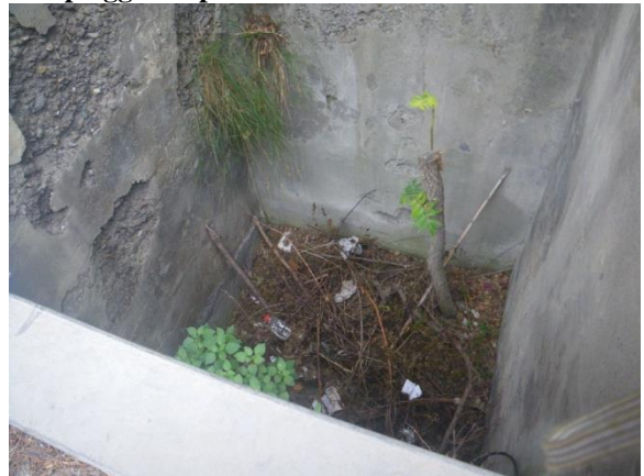
A 4 Canale di scolo Strada provinciale 1
