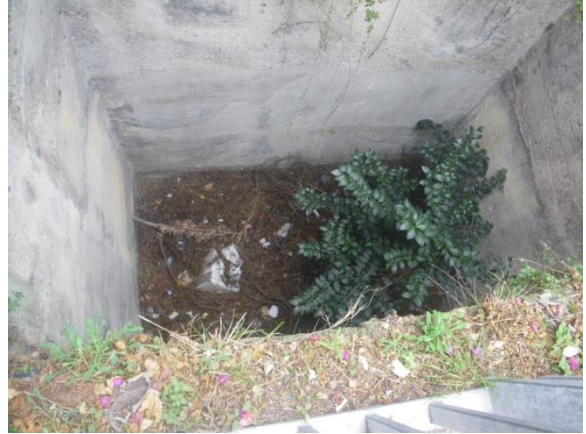
A 7 Canale di scolo Strada provinciale 1
